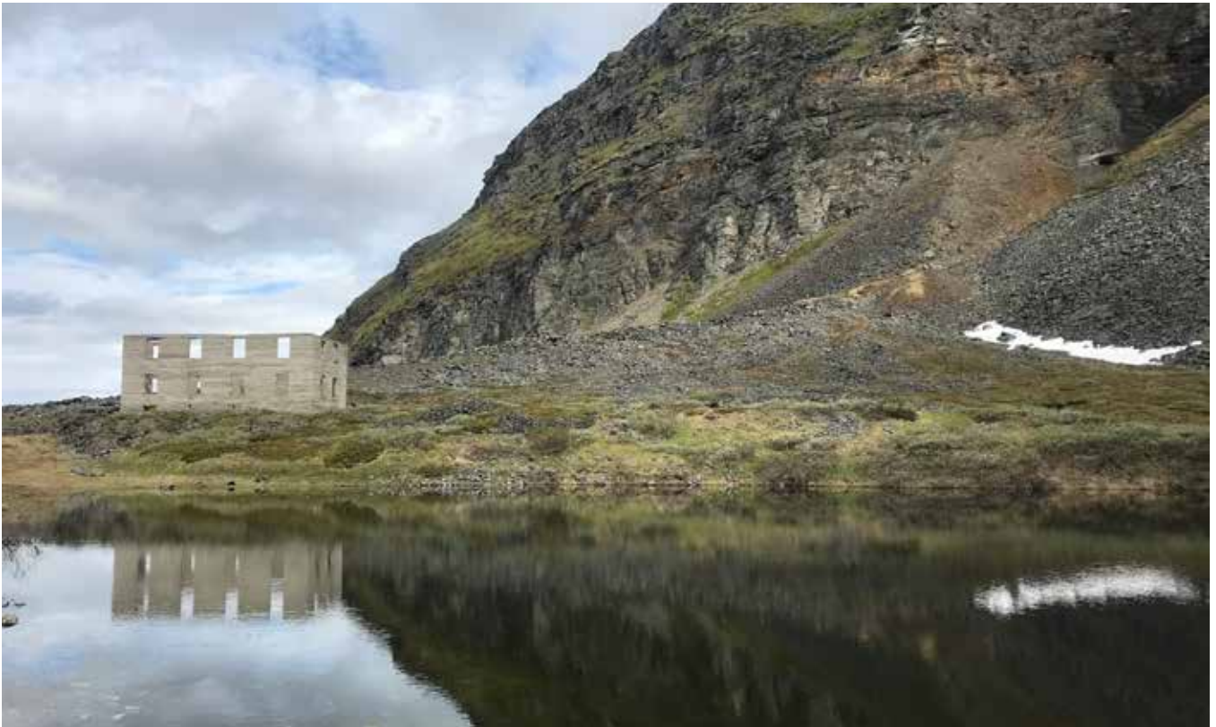
Støypbrakka og tufter nede ved vannkanten i Sabetjohk. Til høyre skimtes en av gruveinngangene i fjellet. Foto: Kåfjord kommune.
