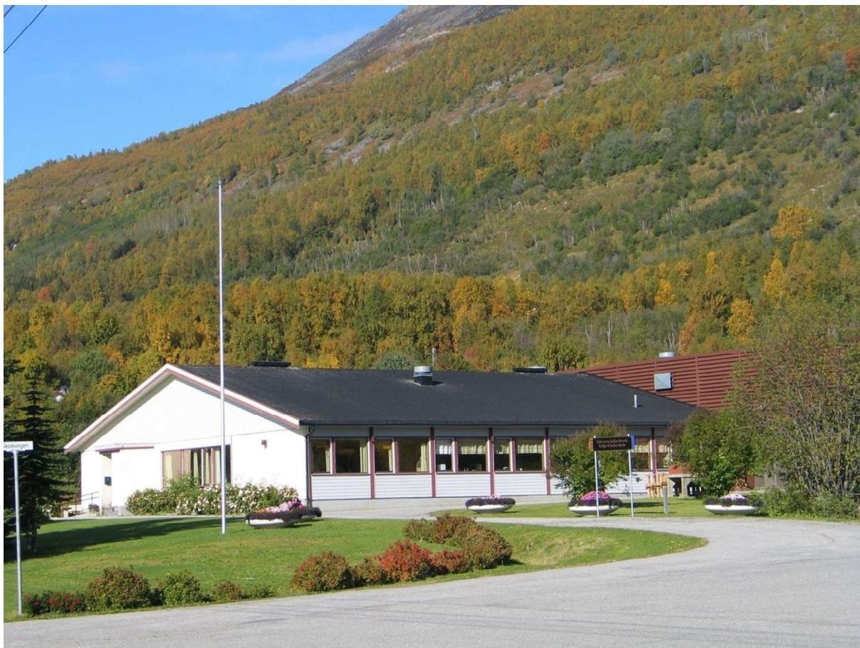
Foto: Kåfjord Kultursenter i Olderdalen som i skrivende stund er i ombygging for å huse bibliotek, kulturskole, digital ungdomsklubb og samfunnshus.
