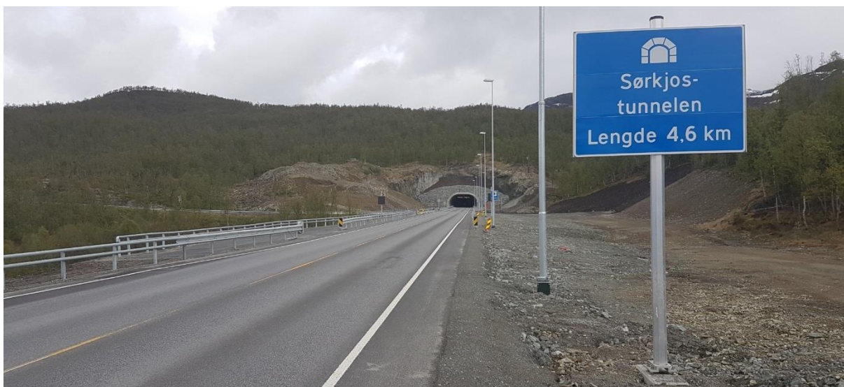
Sørkjostunnelen (Foto: Transportutvikling AS)
